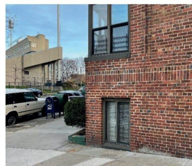
b. Parapet okna piwnicznego w pobliżu poziomu chodnika.
