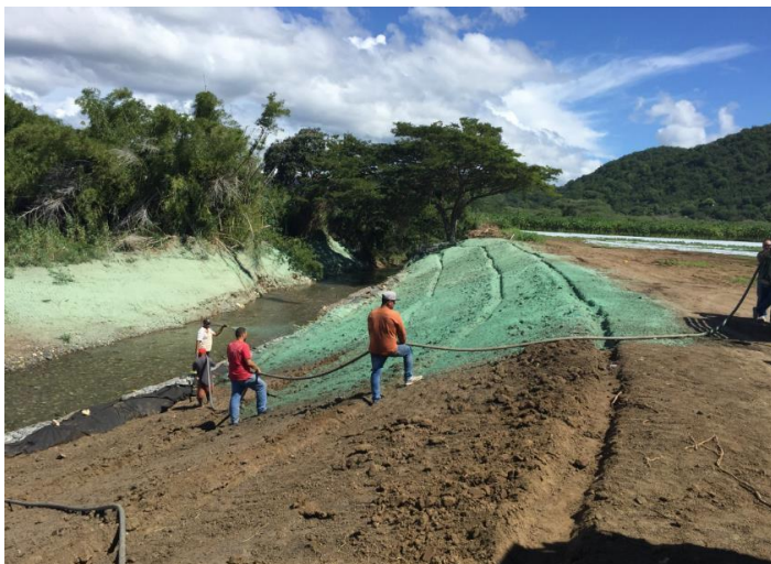
Ilustración 2-1: Hidroslembra realizada por Protectores de Cuencas para ayudar a restaurar las riberas del río Loco en Yauco (Crédito de la foto: PDC)
