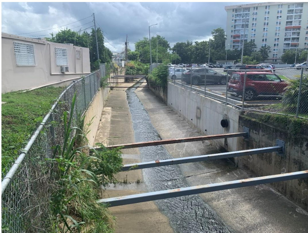
Ilustración 1-3: Fallo de muros de concreto de canal trapezoidal a lo largo de la quebrada Buena Vista, entre el complejo de edificios residenciales Jardines Metropolitanos y la comunidad Ramón Nevárez en San Juan. (2023).
