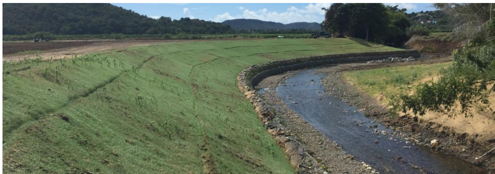
Ilustración 3-1: Hidroslembra en las riberas del canal río Loco. (Crédito de la foto: PDC)
