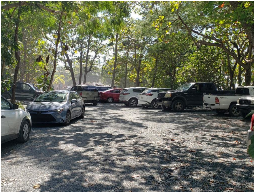
Ilustración 2-6. Estacionamiento permeable en Rincón, Puerto Rico (Protectores de Cuencas, 2024)
