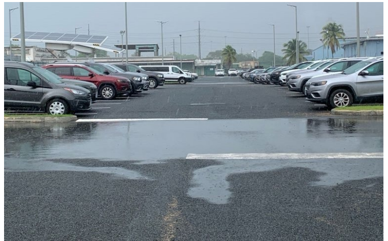
Ilustración 2-5. Estacionamiento permeable en el Centro Guaynabo de la GSA luego de una lluvia por la tarde, que muestra el agua infiltrándose lentamente en el pavimento, recargando el agua subterránea y reduciendo las escorrentías en la ubicación. La zona mojada corresponde a pavimento estándar colocado para sostener un tráfico más intenso, mientras el resto del estacionamiento cubierto con pavimento permeable.
