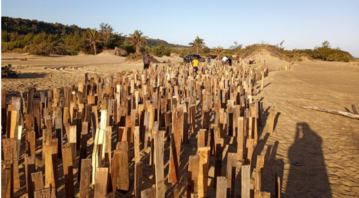
Ilustración 0-13: Diseño típico de matrices de biomímica (R.J. Mayer, usado con permiso)
