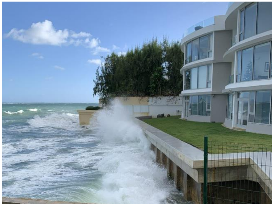
Ilustración 00-2: Arriba: antigua playa de arena en Punta Las Marías en San Juan, Puerto Rico. Abajo: mismo sitio después de la construcción de un mamparo de tablestacas de acero con una tapa de hormigón para controlar el oleaje y las inundaciones costeras. El mamparo agravó la pérdida de arena, una mayor erosión costera en la punta de la estructura, la reducción del acceso público y la pérdida de valores recreativos y ecológicos que antes se asociaban a esta zona de playa (N. Pérez, usado con permiso).
