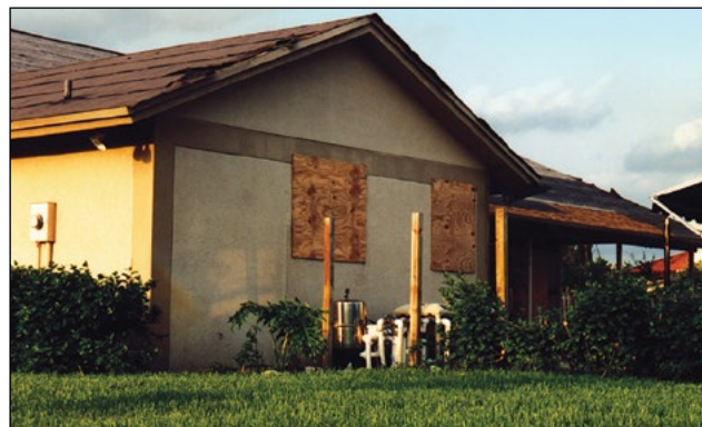
Imagen 1. Los paneles estructurales de madera instalados conforme a los requisitos del código de construcción son una manera económica de protección, pero deben estar fijadas adecuadamente para que no se conviertan en escombros arrastrados por el viento.
