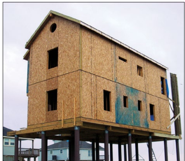
Imagen 2. Construcción de una casa con paneles estructurales aislantes.
