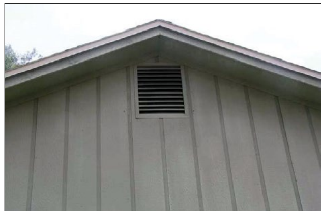
Imagen 9. Rejilla de ventilación del extremo del hastial.
