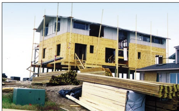
Imagen 2. Adición vertical a una vivienda dañada por el huracán Fran. La vivienda de 1 planta preexistente se convirtió en la segunda planta de una vivienda elevada para cumplir con los nuevos requisitos de elevación para cimientos y pisos.
