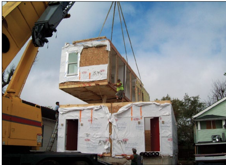
Imagen 1. Construcción de una casa modular.
