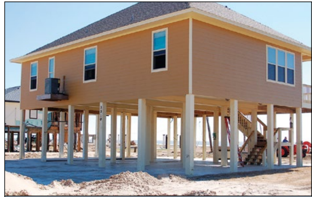
Imagen 2. Las paredes desprendibles debajo de este edificio fallaron según previsto bajo las fuerzas de inundación del huracán Ike.
