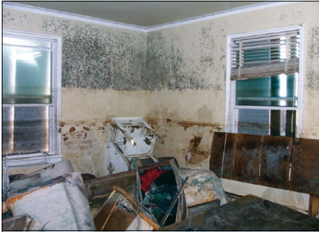
Imagen 6. El hongo o moho y la contaminación biológica y química también son preocupaciones cuando los niveles de inundación superan el piso más bajo. La contaminación también podría causar que el edificio no se pueda reparar o, por lo menos, que la limpieza, la restauración y las reparaciones sean más costosas y tomen más tiempo.
