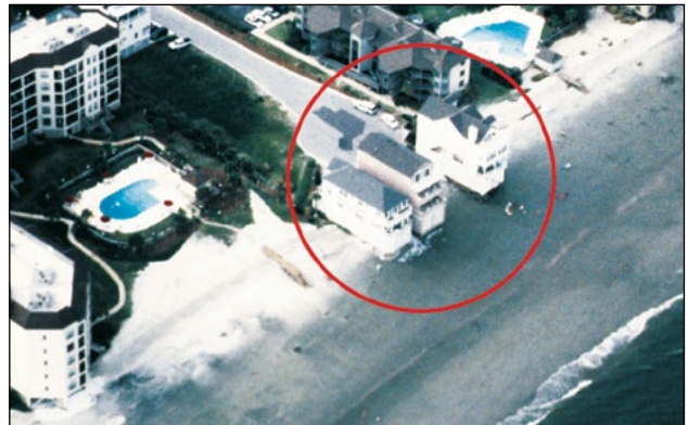
Imagen 1. Edificio bien construido, pero mal ubicado.
