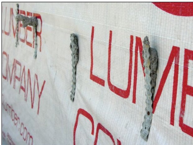
Imagen 5. Estos cuatro sujetadores nunca estuvieron incrustados en la junta de cemento.
