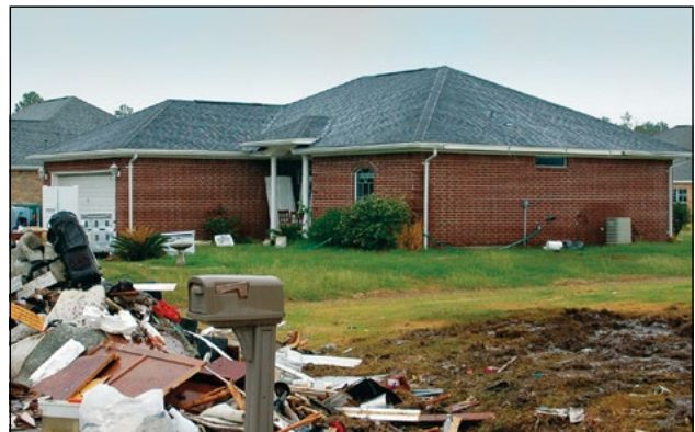
Imagen 1. Bridge City, Texas, las viviendas se inundaron durante el huracán Ike aunque fueron construidas fuera del SFHA y en la Zona B. El nivel de inundación fue de aproximadamente 4 pies sobre el BFE más cercano.
