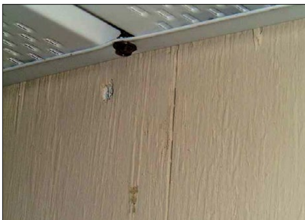
Imagen 5. Tornillos a través de la canaleta de la pared.
