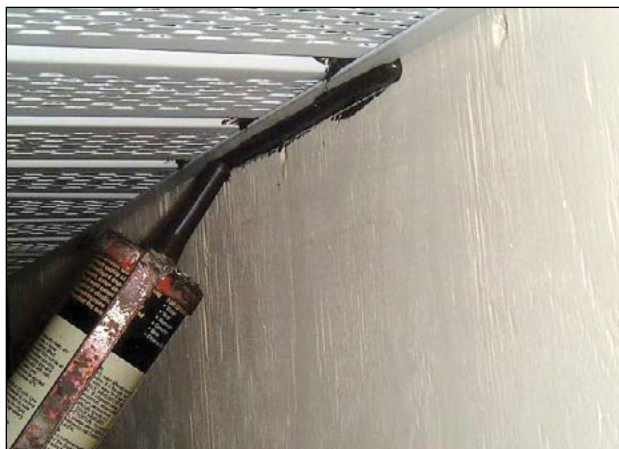
Imagen 3. Aplicación de una gota de sellador. (Nota: Se usó sellador negro para que se viera en la fotografía. Por lo general se usa un color de sellador que no resalte tanto.)
