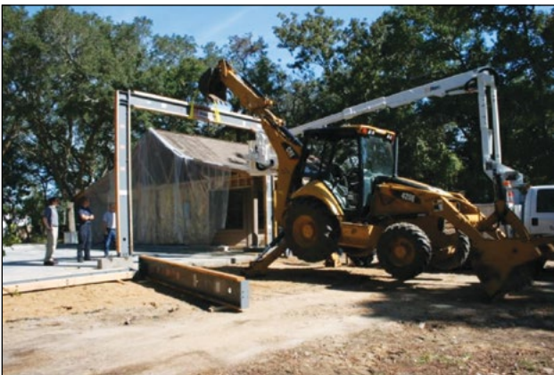
Imagen 4. Instalación de un marco resistente a momento ordinario prefabricado.
