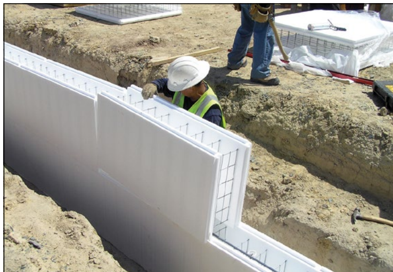
Imagen 3. Ejemplo de pared de ICF y acero de refuerzo antes de verter el hormigón. Las formaletas se dejan en su lugar una vez vertido el hormigón.
