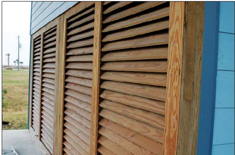
Imagen 1. Las persianas de madera instaladas debajo de una casa elevada en una Zona V son una buena alternativa para las paredes desprendibles sólidas.
