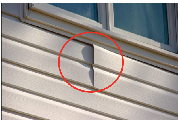
Imagen 6. Es importante la atención a los detalles y otros obstáculos alrededor de las ventanas. Use la moldura para cables de servicios públicos, golpee el panel para engancharlo de un clic y no lo solape justo debajo de una ventana.
