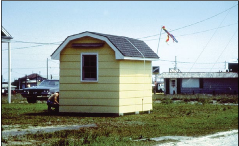
Edificio adjunto pequeño anclado para resistir las fuerzas de los vientos.
