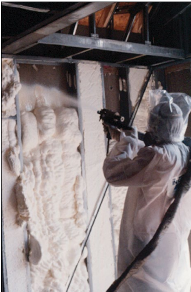
Imagen 5. Ejemplo de la cavidad de un muro rellena de aislamiento con espuma de célula cerrada aplicada por proyección.
