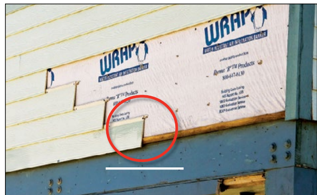
Imagen 12. El revestimiento exterior con clavos ocultos instalado con una separación expuesta en la parte inferior (círculo rojo) podría fallar.
