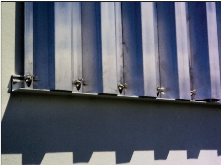
Imagen 2. Panel de tormentera de metal. La tormentera está instalada en rieles fijados permanentemente arriba y debajo del marco de la ventana. La tormentera está colocada en el riel y asegurada con tuercas de mariposa a los montantes montados sobre el riel. Este tipo de tormentera es efectivo y se instala fácilmente mientras el sistema de tuercas de mariposa y montantes ofrece un método seguro de anclaje. Los diseños del riel que cuentan con montantes montados permanentemente para las tuercas han demostrado ser más confiables que los diseños de rieles que usan montantes que se deslizan por el riel.
