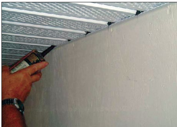
Imagen 4. Aplicación de gotas de sellador.
